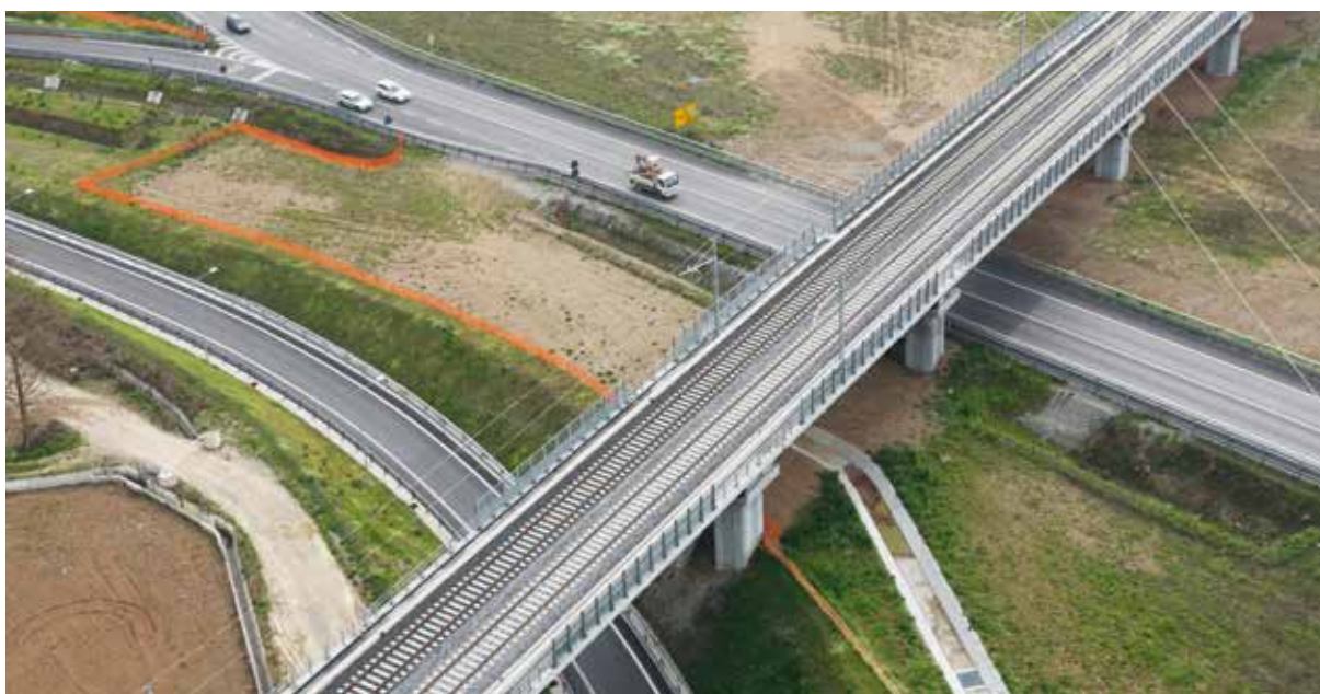
Consorzio Cepav Due: lavori di realizzazione della tratta ferroviaria alta velocità Treviglio-Brescia
