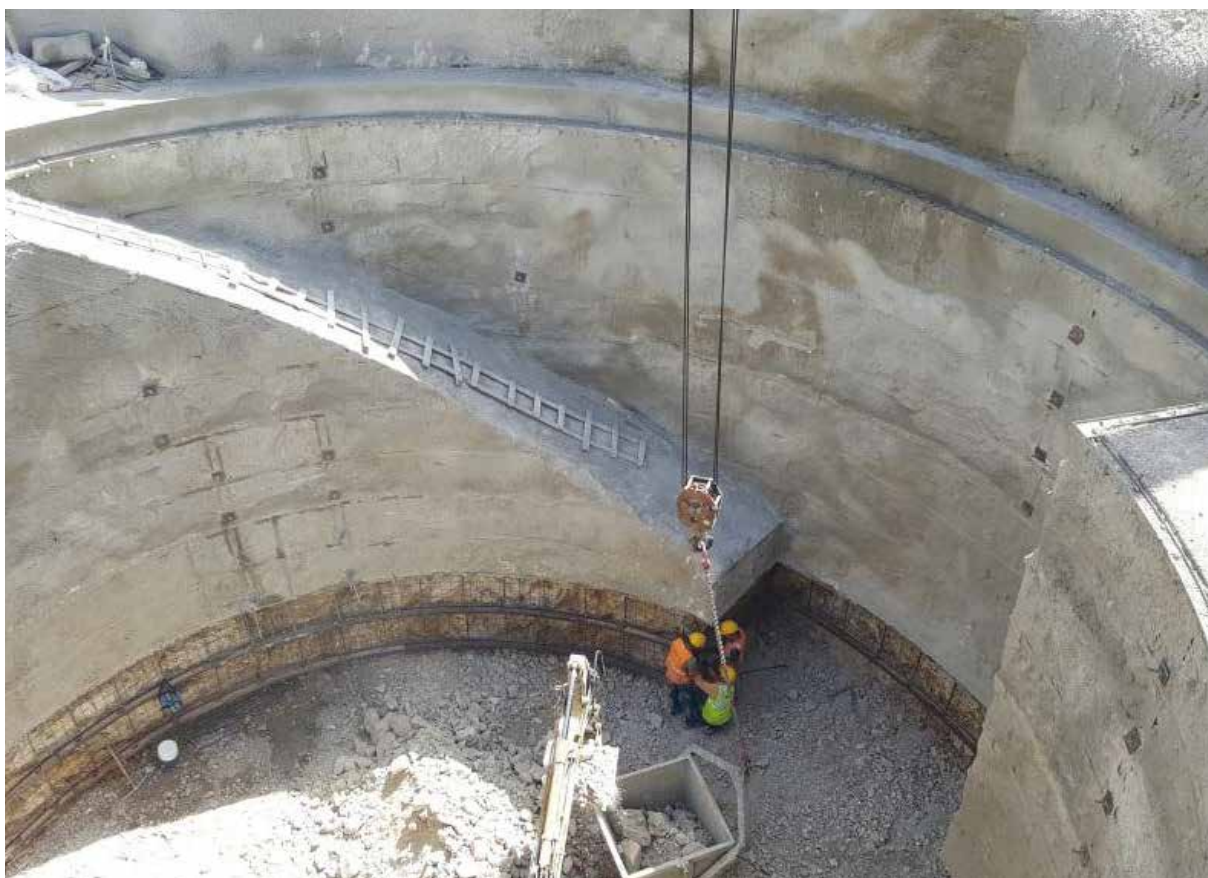
Diga di Mseilha - Ministero dell'Energia e dell'Acqua del Libano
