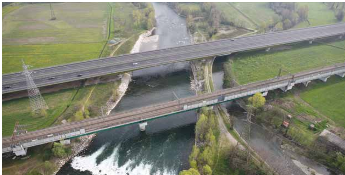
Consorzio Cepav Due: lavori di realizzazione della tratta ferroviaria alta velocità Treviglio-Brescia
